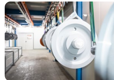
Neue Trocknungsanlage mit Wärmerückgewinnung
