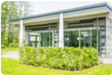
La zona exterior de la cantina invita a quedarse
