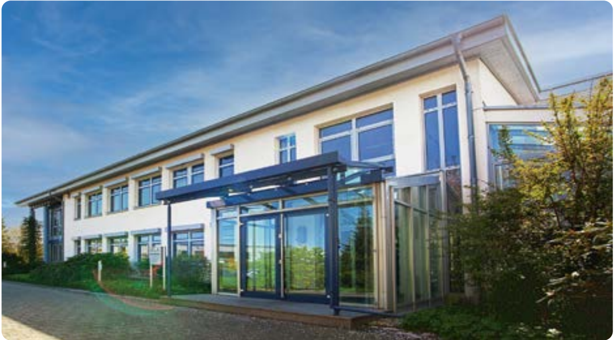
Das Verwaltungsgebäude, seit 1998 der Hauptsitz des Unternehmens
