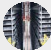
设备制造 工艺工程、能源工程、 建筑服务工程和制造工程等
